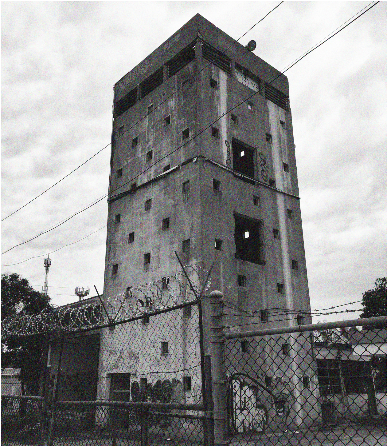
Fig. 1 Vista Exterior Farmoquímica del pacífico. Fuente: Recurso del Autor.
