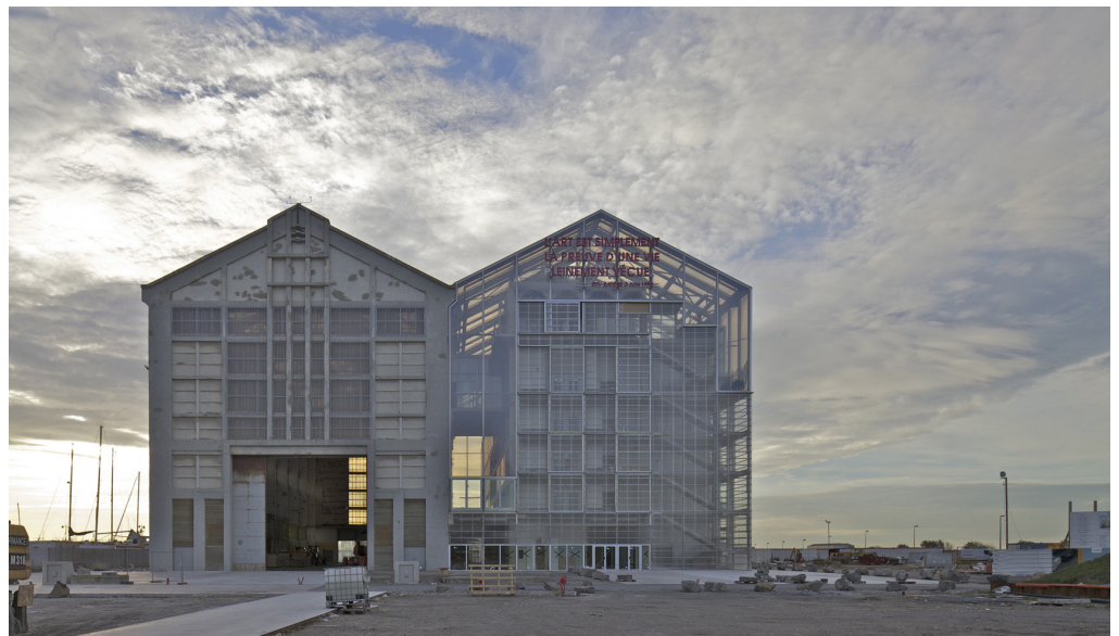
Fig 4. Vista exterior edificio FRAC.
