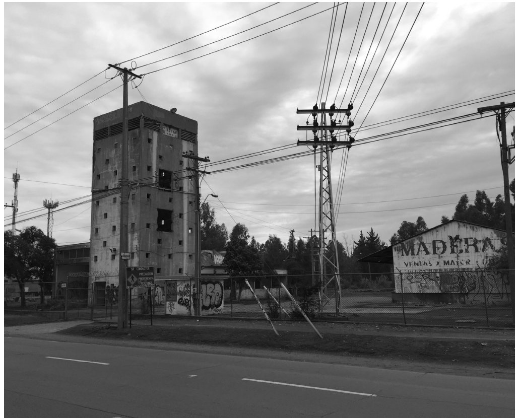
Fig 27. Vista actual Farmoquímica de Puente Alto desde Av. Eyzaguirre.
