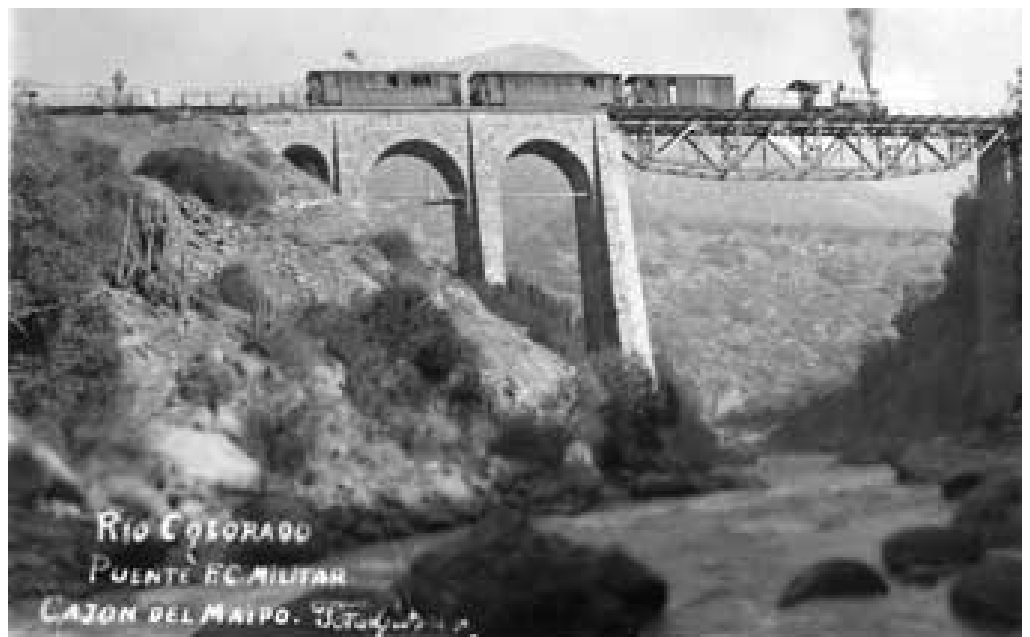
Fig 19. Puente Ferroviario el Colorado, Ruta Puente Alto - Cajón del Maipo.
