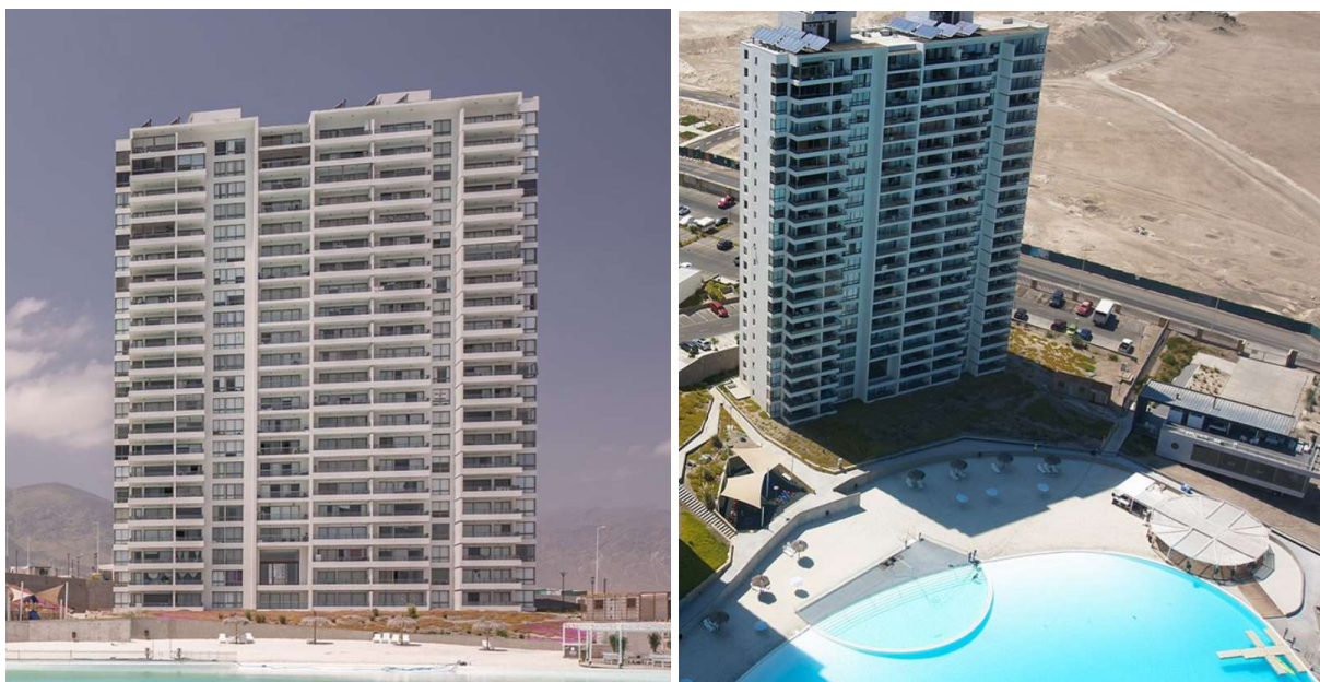
FIGURA 2.1: FOTOS ACTUALES DEL PROYECTO (FUENTE: ELABORACIÓN PROPIA)
