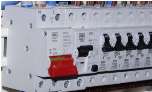
Figura 4.13: Disyuntor de protección eléctrica ubicado en armarios eléctricos. [13]
