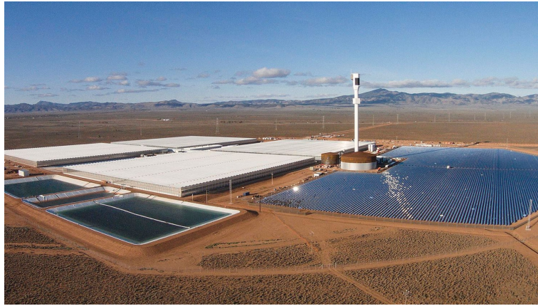
Figura 2.3: Proyecto instalado en Port Augusta, Australia.[14]
