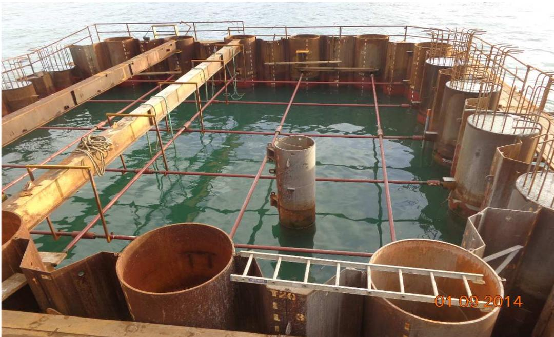
Sistema de Muro de rompeolas con pared de tablestacas y pilotes
