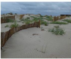
Reconstrucción de duna de apoyo
