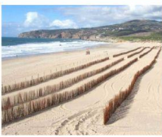
Reconstrucción de duna estructural
