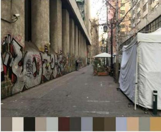
Fachada de estacionamiento en desuso
