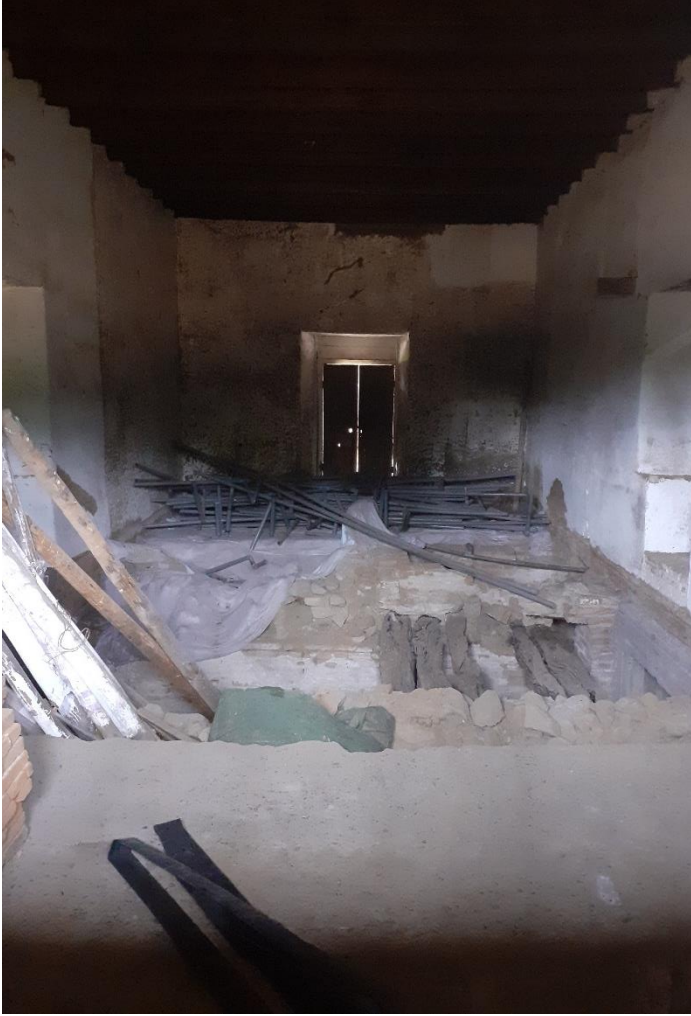
Figura 15: Elaboración propia. Foto estado actual de piso inferior o cárcavo.
