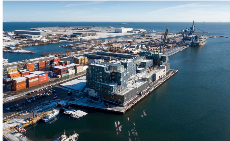
Imagen 26. Vista exterior Escuela Internacional de Copenhague
