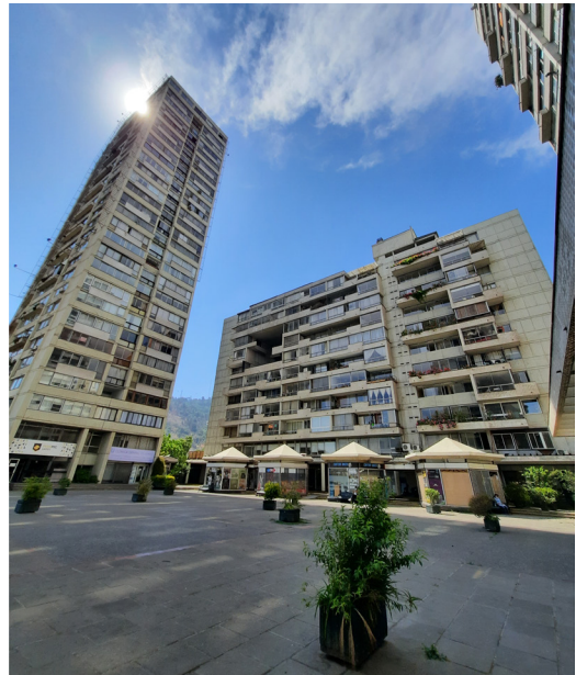
Conjunto Torres de Tajamar Fuente: Arq. Aránzazu Torrontegui.
