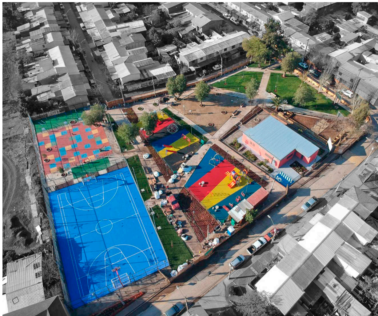
Fig. 45. Vista aérea Plaza Mafalda. Fuente: Premio Aporte Urbano, 2019.
