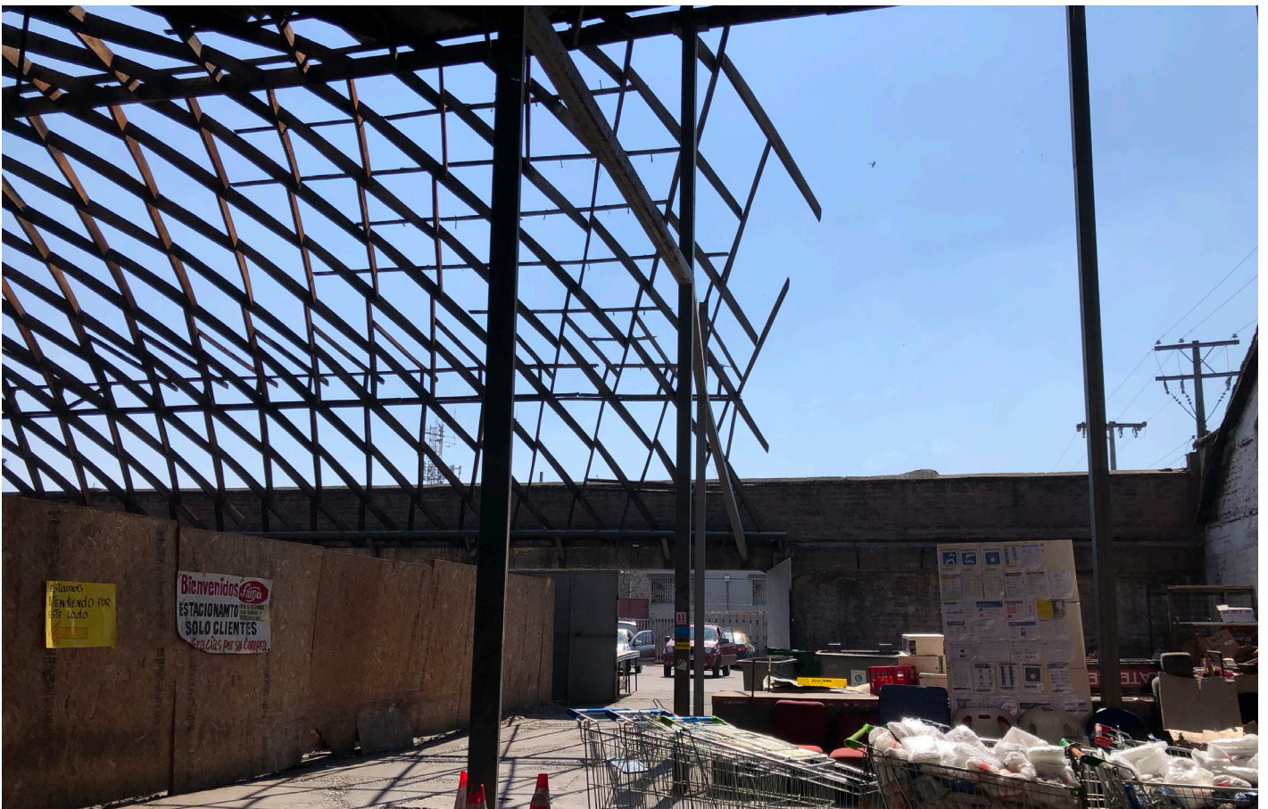
Imagen 26. Estado actual del inmueble 3. Elaboración Propia.
