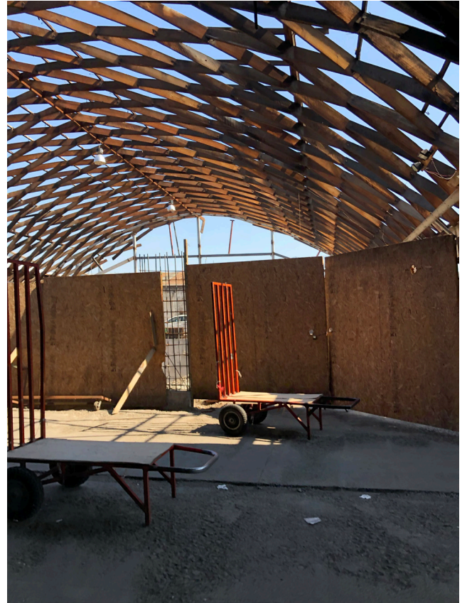
Imagen 24. Estado actual del inmueble 2. Elaboración Propia.
