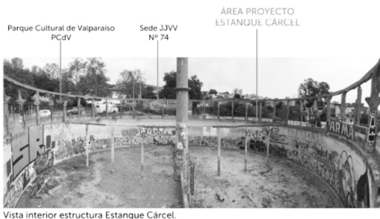
Vista interior estructura Estanque Cárcel.
