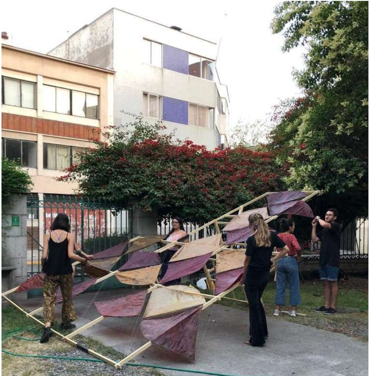
Figura 67. Equipo de Proyecto - Anclaje de Bastidores y Paños a la Estructura. Autoría Propia
