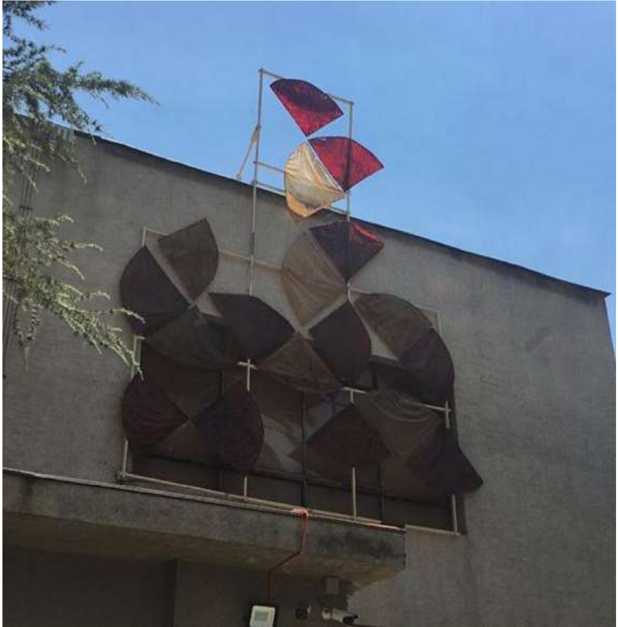
Figura 70. Obra Biofachada . Autoría Propia
