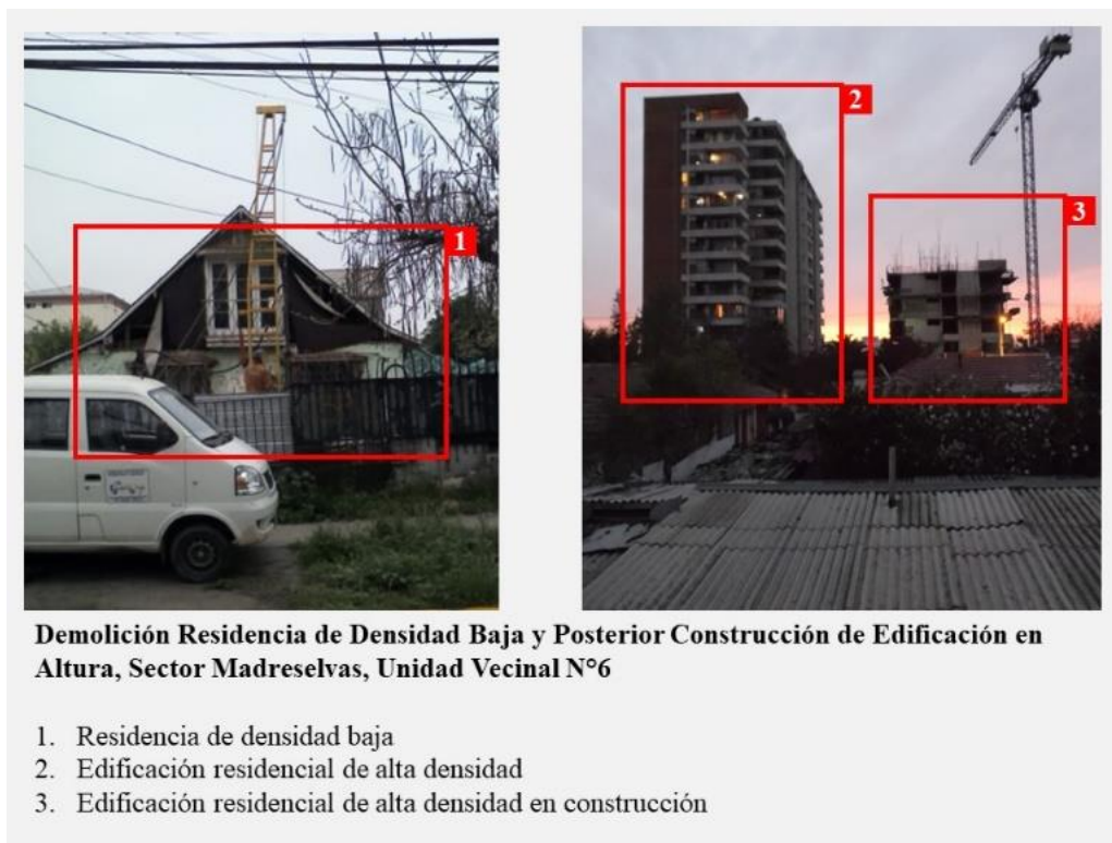
Figura N°12: Demolición Residencia de Densidad Baja y Posterior Construcción de Edificación en Altura, Sector Madreselvas.
