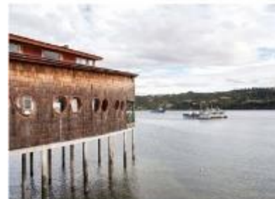
Imagen 33: Cocinería la Dalca, 2008 Fuente: Google
