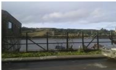
cerco de separación
