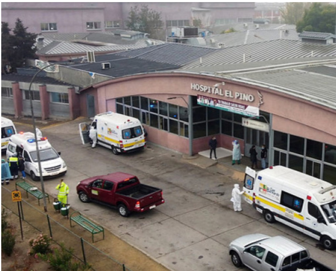
IMAGEN 2. HOSPITAL DEL PINO DE ALTA COMPLEJIDAD PARA EL SERVICIO DE SALUD PÚBLICO SUR. UBICADO A 3 KM DIRECTO POR AVENIDA REGINA VALDEZ.
