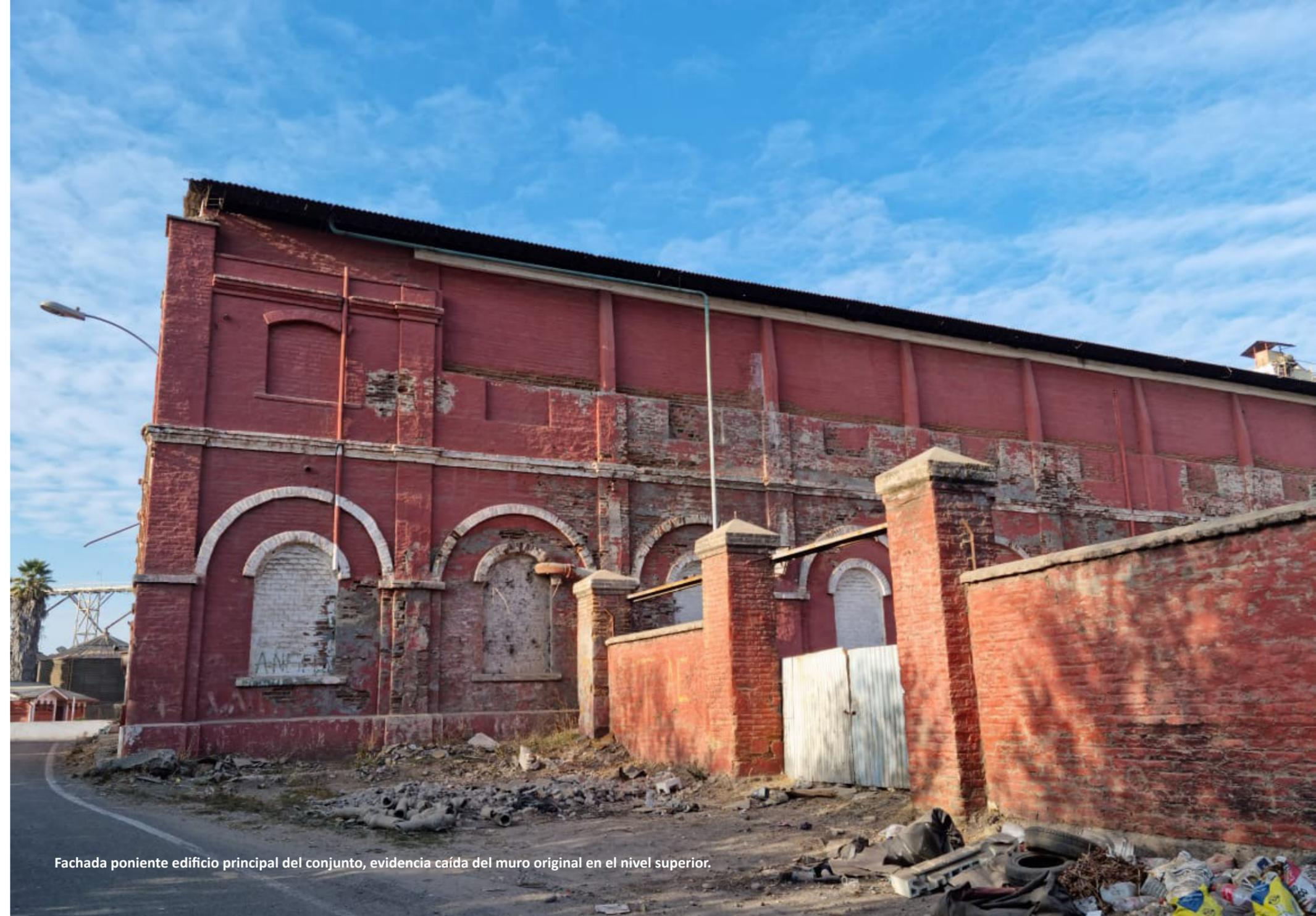
Fachada poniente edificio principal del conjunto, evidencia caída del muro original en el nivel superior.
