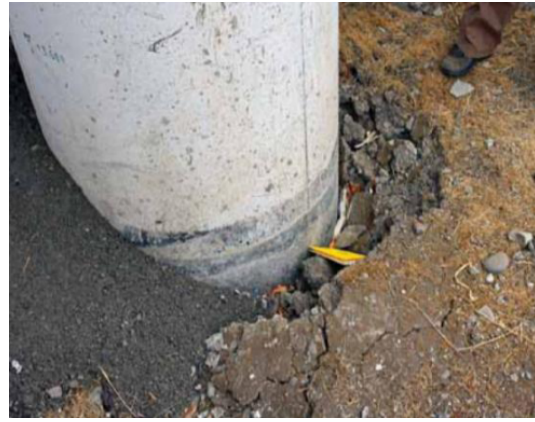
(b) Separación de columna.
