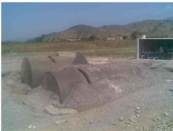
(a) Flotación de estructura enterrada en Lampa.
