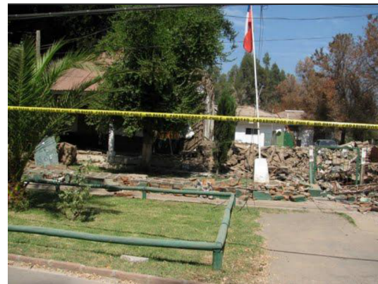
(b) Comisaría totalmente destruída.
