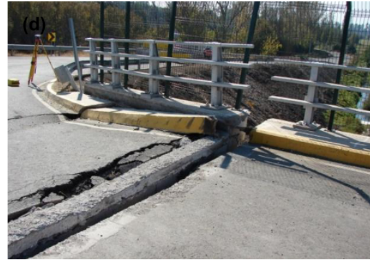
(b) Asentamiento en terraplén.
