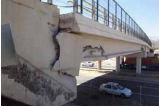
(a) Rotación de tablero.
