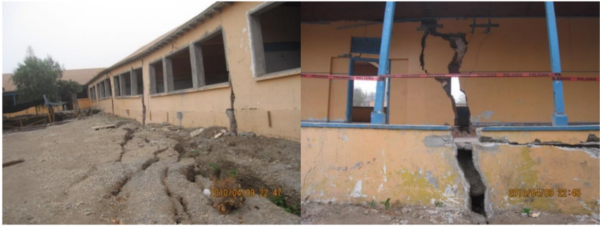
Figura 3.1.1: Daños en escuela Elías Sánchez Ortúzar en Champa. Fuente: Moffat y Ruz (2018).
