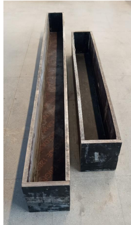
(c) Moldes para Vigas
