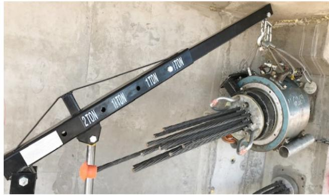
Figura 39: Fierros hormigón postensado
