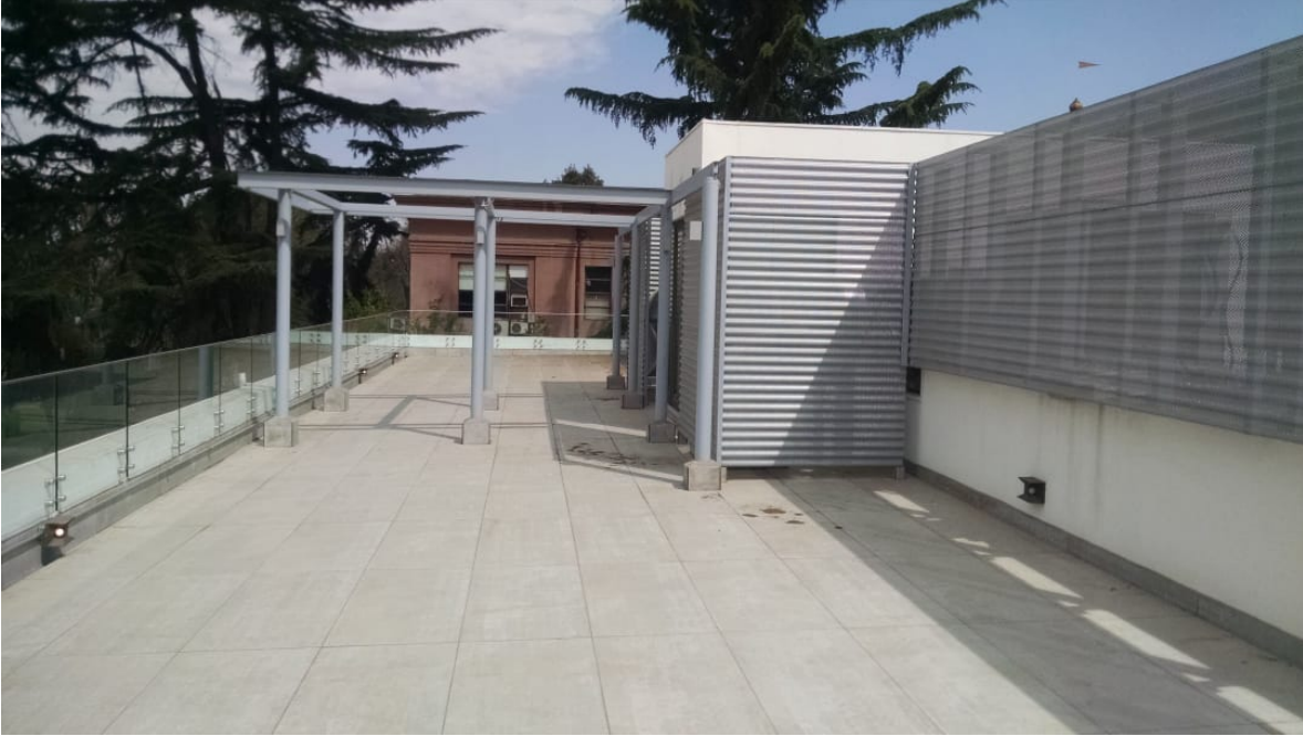
Figura 6.1: Techo del Centro de Energía vista Sur.
