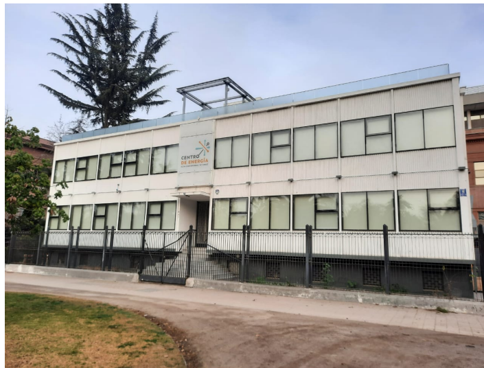
Figura 5.1: Edificio del Centro de Energía
