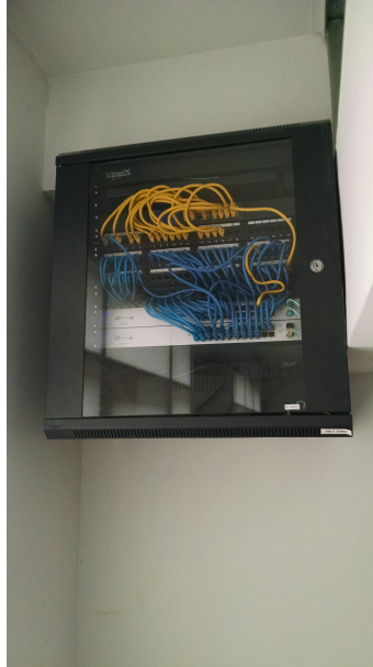
Figura 5.6: Servidor - Centro de Energía
