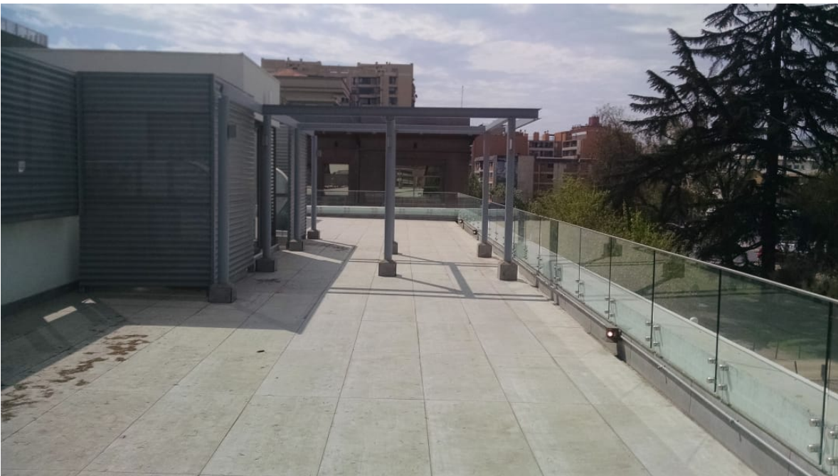
Figura 6.2: Techo del Centro de Energía vista Norte.
