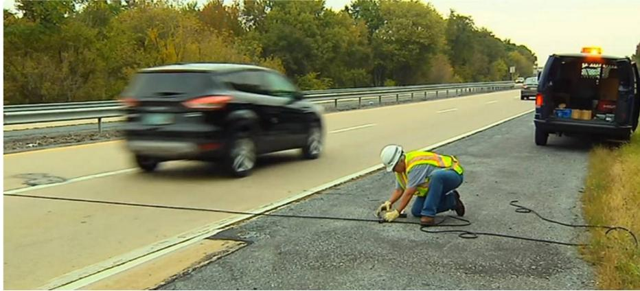
Figura 2.3: Imagen referencial de detector neumático, extraído de <https://www.diariomotor.com/noticia/cables-carreteras-funcion/>
