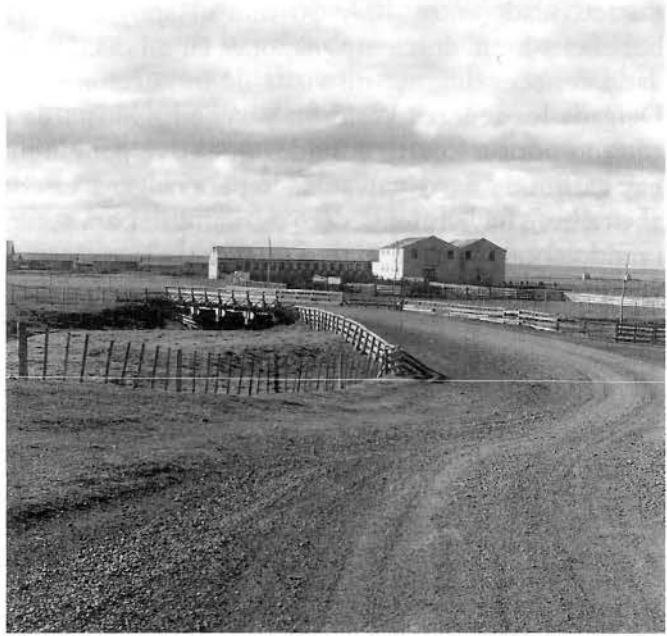
Figura 15. Puente, galpón de esquila y matadero en la estancia San Sebastián.
