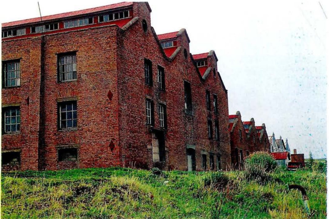
Figura 24. Pabellones en mampostería de ladrillo en el Frigorífico Bories.
