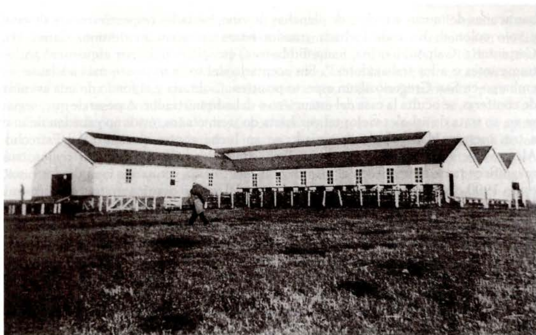
Figura 43. Galpón de esquila en la estancia Laguna Blanca (Demolido).
