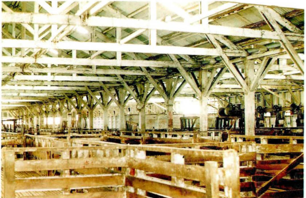
Figura 68. Vista interior del galpón de esquila de la Estancia Oazy Harbour.
