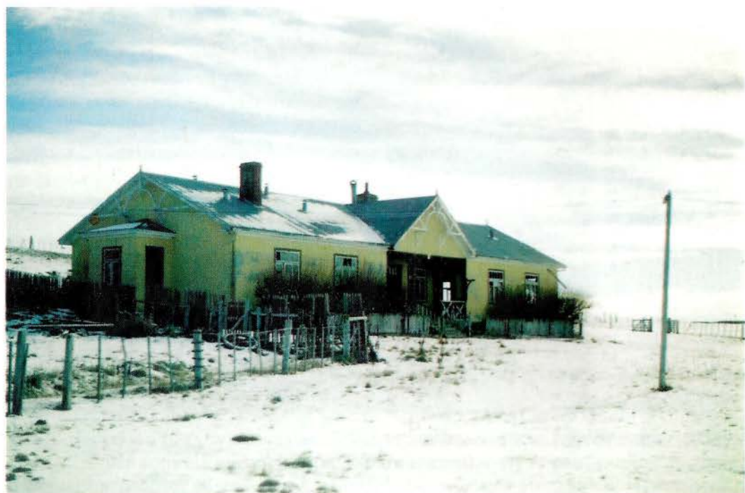
Figura 53. Cocina-comedor de los trabajadores en Laguna Blanca.
