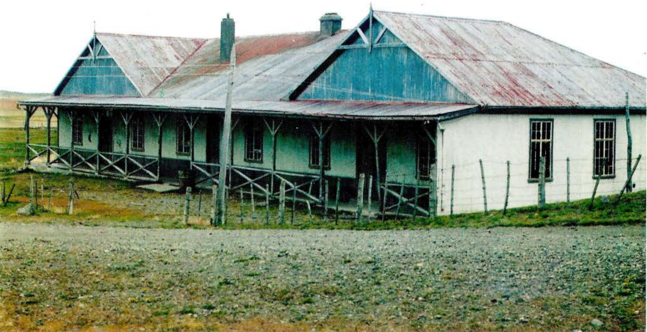
Figura 74. Cocina-comedor para trabajadores en Oazy Harbour.
