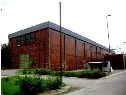
Casa de máquinas ex Chilean Electric Tramway Co. 1897. YM3.
