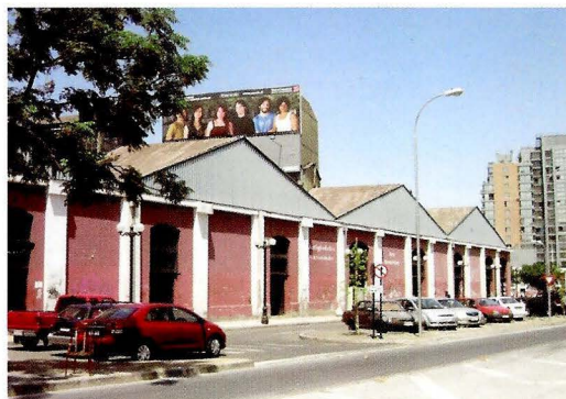
Naves de tranvías ex Chilean Electric Tramway Co. 1908. YM6. Archivo de la investigación. Fotografía de los autores.
