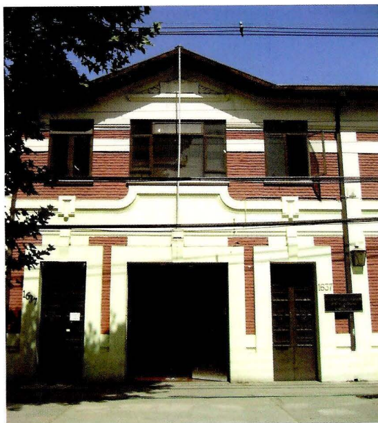
Ex Compañía Industrial de Catres, actual ONEMI. 1912. ASD17. Archivo de la investigación. Fotografía de los autores.
