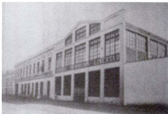
Figura 46: Talleres de la ex Fundación Libertad, actual Universidad ARCIS (1972). En Seminario U. Chile "Patrimonio Arquitectónico Industrial en el Anillo de Circunvalación de Santiago y su relación con el Proyecto Bicentenario. El caso del eje Balmaceda-Matucana". RT15.
