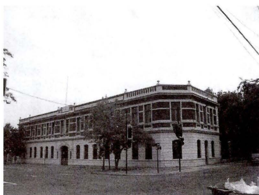
Figura 61: Edificio administración ex Chilean Electric Tramway Co. 1900. YM4.
