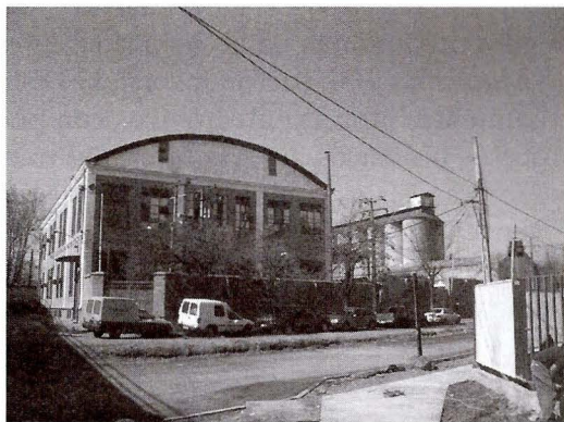
Figura 57: Central de la Compañía de Teléfonos. RT25. Archivo de la investigación. Foto de los autores.
