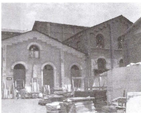
Figura 77: Conjunto San Ignacio-Bio Bío. 1910. ASD5. Seminario U. Chile "Conjunto y Edificio Industrial San Ignacio y Bio-Bío".
