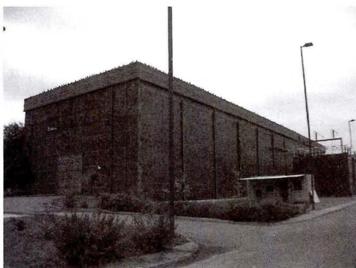
Figura 60: Casa de máquinas ex Chilean Electric Tramway Co. 1897. YM3.
