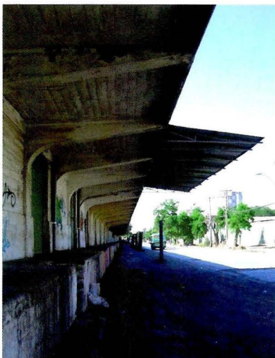
Bodegas FEPASA. Estación Central. RT6. Archivo de la investigación. Fotografía de los autores.
