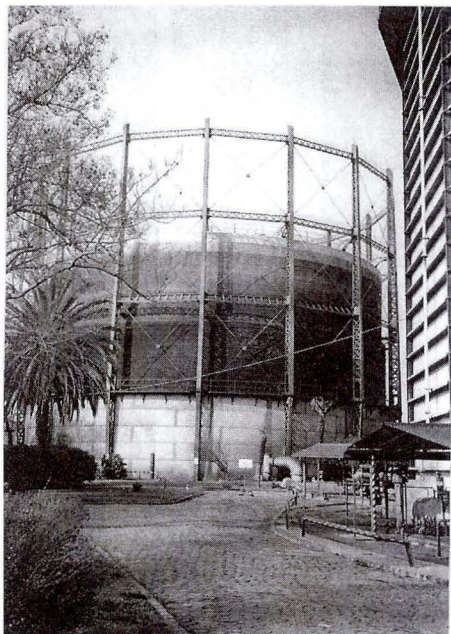
Figura 44: Gasómetro 1 de la Ex Fábrica de la Compañía de Gas de Santiago. En Seminario U. Chile "Arquitectura Industrial del siglo XIX en Chile, la fábrica de gas de San Borja". RT13.
