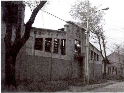
Figura 65: Ex Fundación METALCO. YM8. Archivo de la investigación. Foto de los autores.
