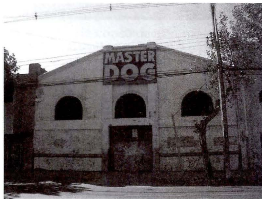
Figura 39: Ex Fábrica de planchas galvanizadas Faisán. c. 1910. Archivo de la investigación. Foto de los autores. RT8.
