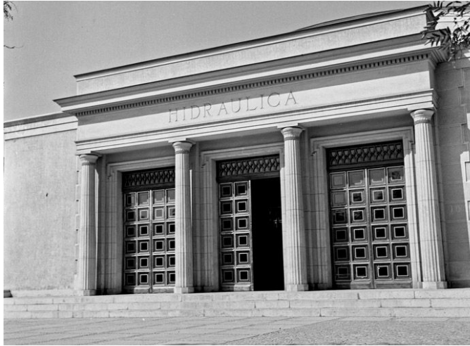
Edificio de Hidráulica. Fotografía de Antonio Quintana.
