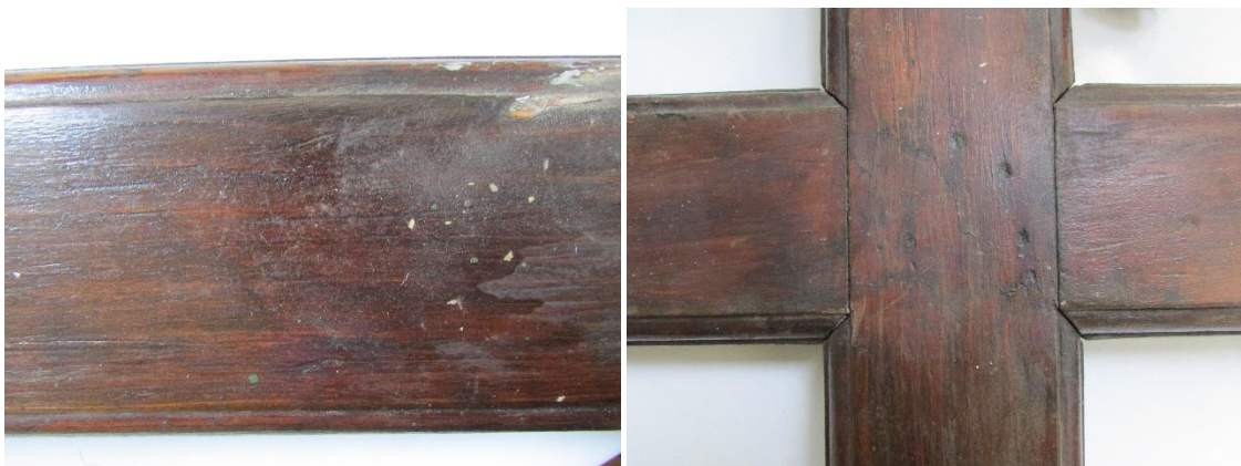
F100 Foto de unión de cruz: ensamble a media madera con Tornillo.
