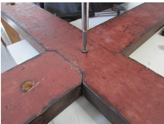
F138 Fotos de desarme en unión de ensamble
