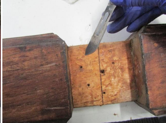
F141 Limpieza mecánica en unión para retirar cola luego de compresas.
