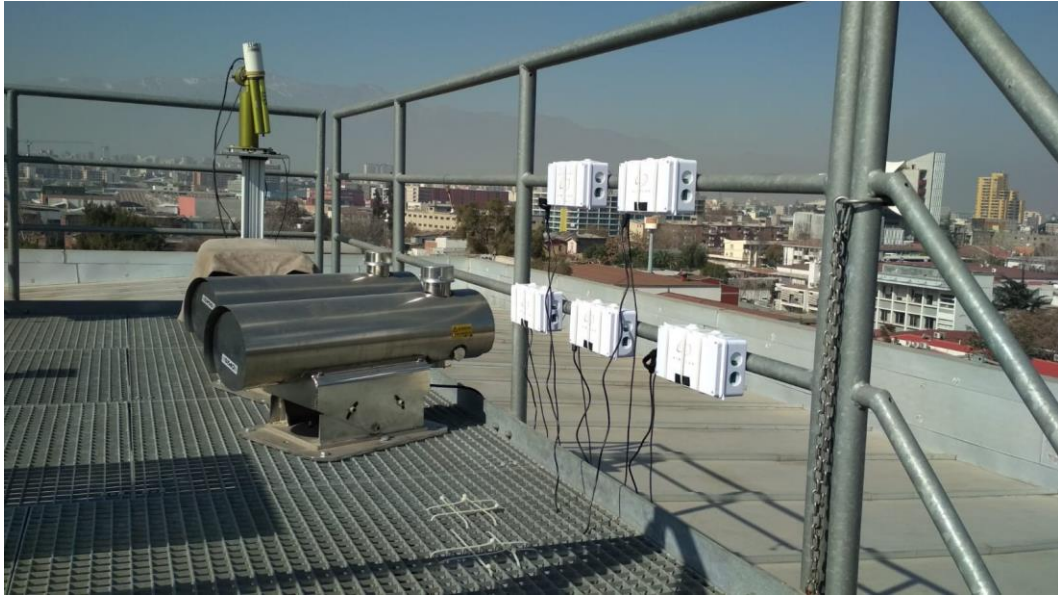
Figura 3.2: Montaje en paralelo de Equipos DOAS y sensores de bajo costo PID para su calibración.
