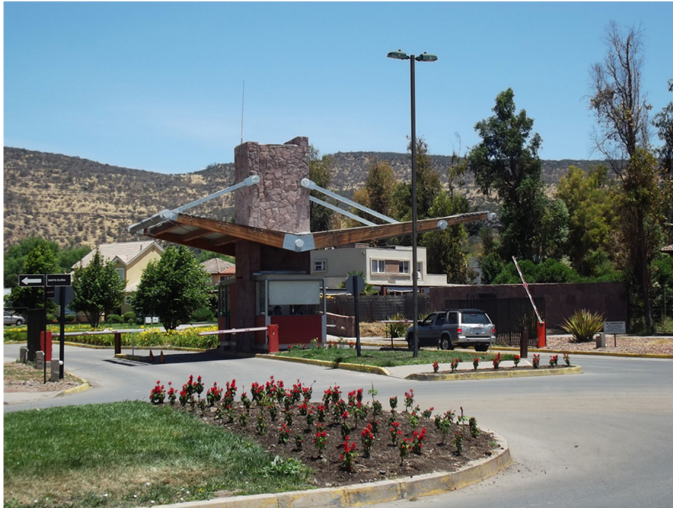
Figura 8 Control de acceso
