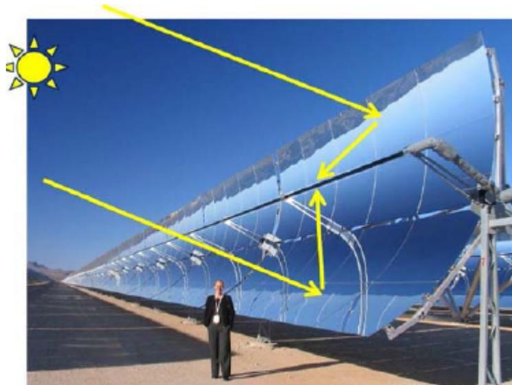
Figura 2.10: Imagen de un colector solar cilindro parabólico [10].
