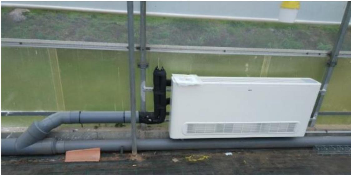
Figura 2.27: Fan coil instalado en un invernadero [43].
