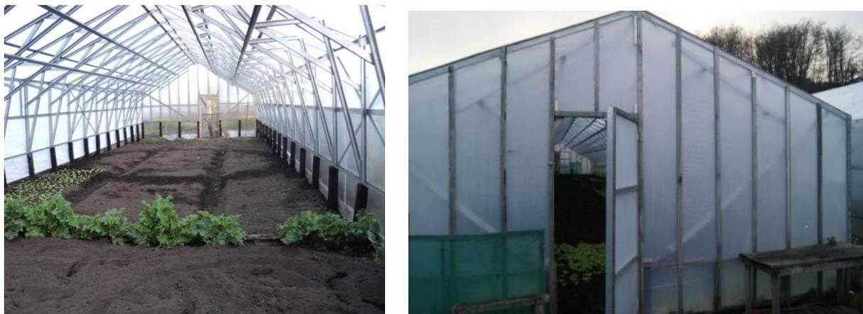
Figura 2.24: Invernadero de estructura metálica a dos aguas [30].
