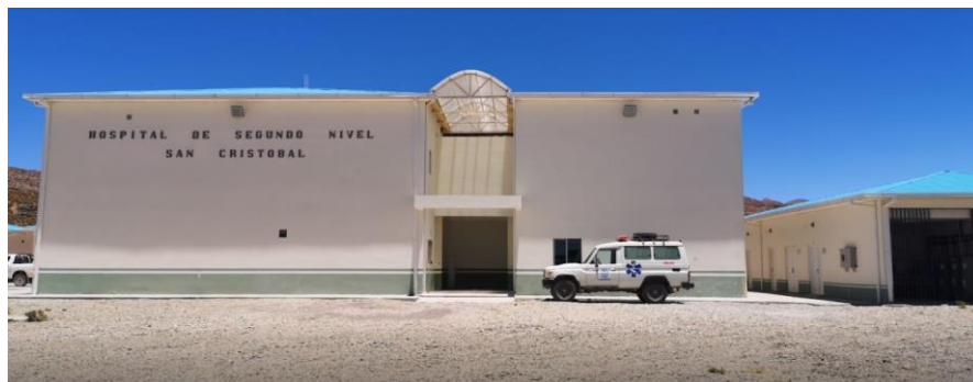
Figura 41: Caso de estudio, proyecto "Centro de Salud San Cristóbal" de constructora Victoria.
