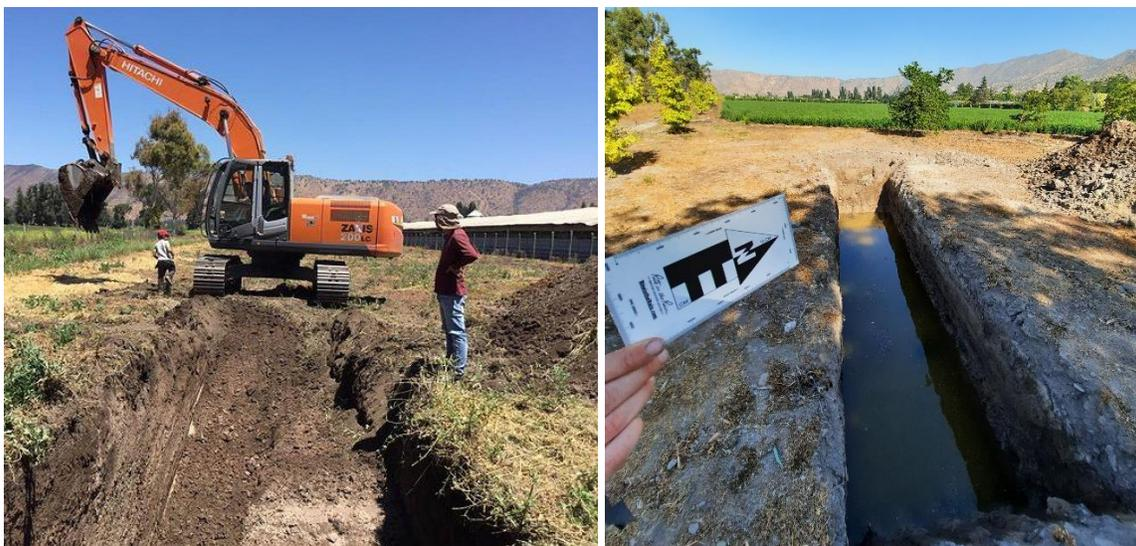
Figura 20: Excavación de Calicatas. (A)Proceso de creación de Calicata 2 con retroexcavadora, ubicada en Fundo la Esperanza. (B)Día siguiente de la excavación de Calicata 1. Se observa con agua en su interior, lo que implicó la necesidad de drenaje para su análisis.
