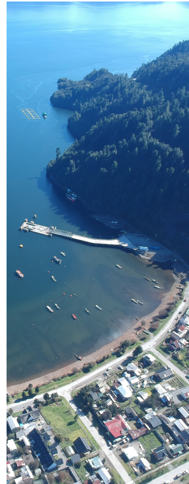
Figura 3: Vista aérea de muelle, Puerto Cisnes. Fuente: Autoría de @conviajeras
