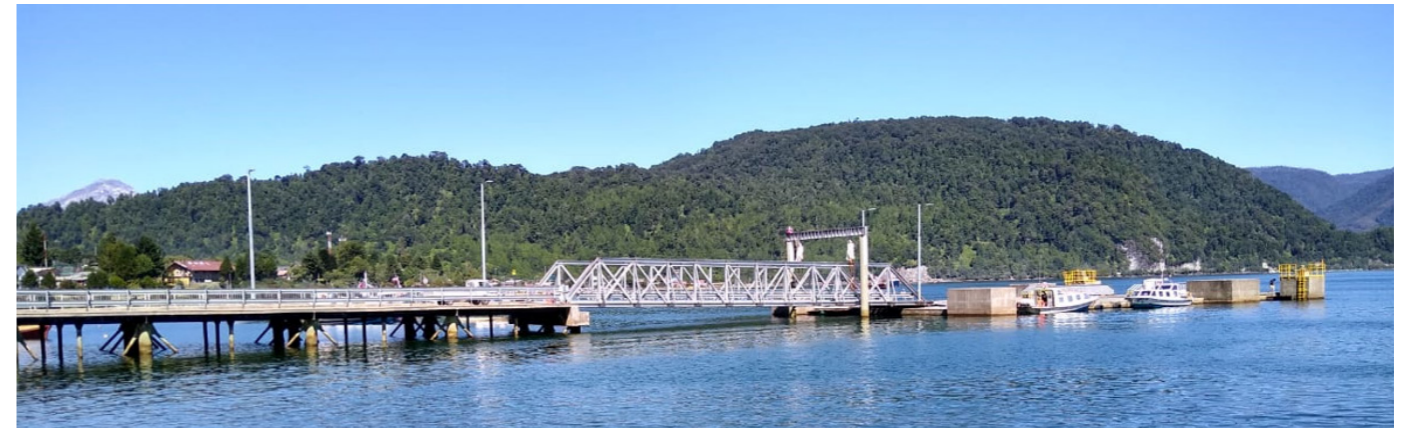
Figura 9: Estructura Muelle Puerto Cisnes. Fuente: Autoría Propia.
