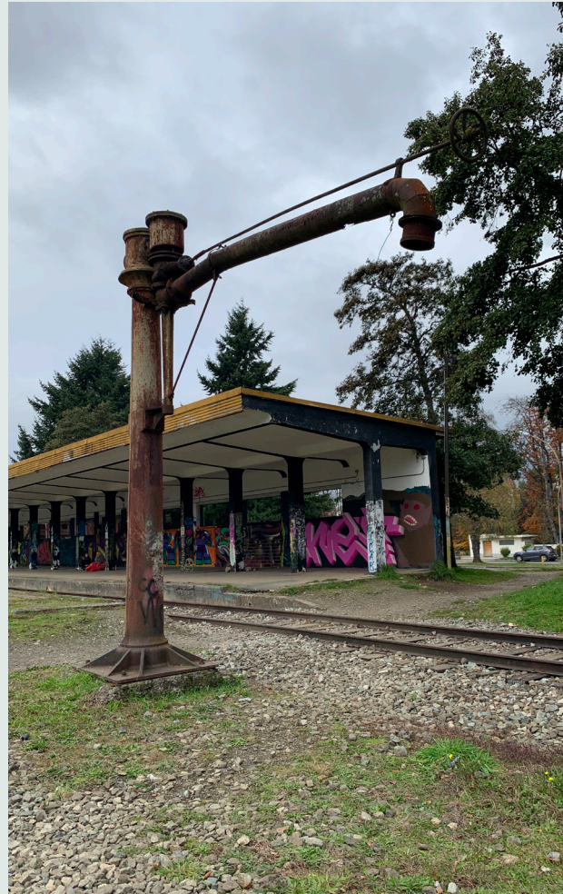
Imagen 3: Infraestructura Férrea Fuente: Elaboración propia.
