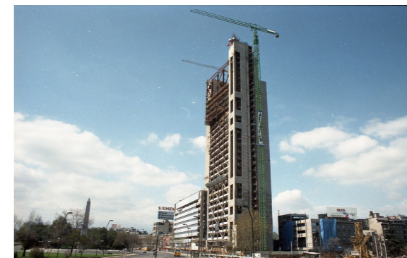
Figura 23: Construcción Torre CTC. Fuente: Emol.
