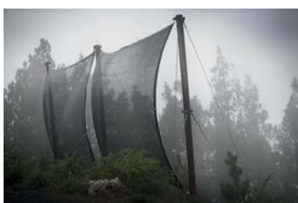
[Img. 38]: Estructura tradicional de un atrapanieblas. [Img. 39 -40 - 41]: Elementos de un atrapanieblas.
