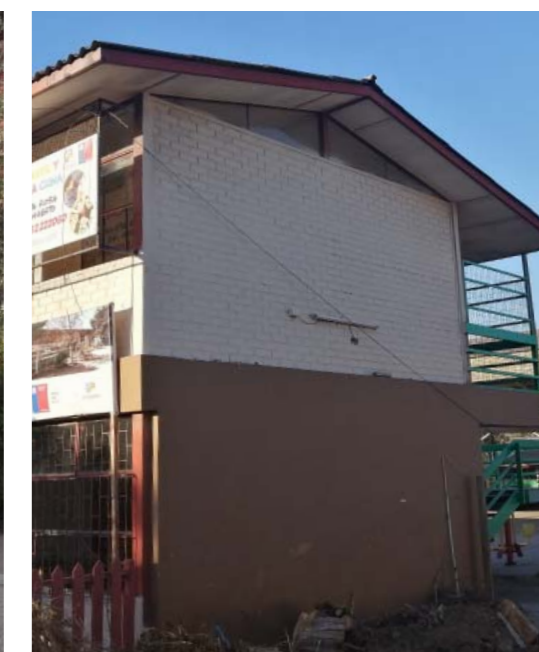
Imagen 68_Construcción hormigón - ladrillo
