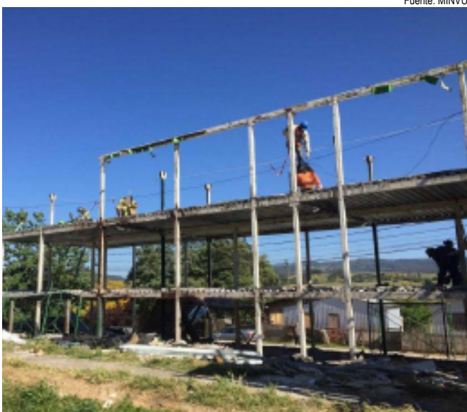
Imagen: Demolición Los condores TEMUCO Fuente: MINVU
