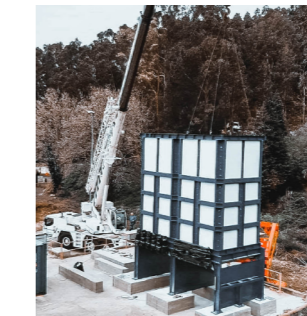
Figura 32 Proceso de montaje de módulos de fermentación. (Empresa Traco Iberia, 2021)
