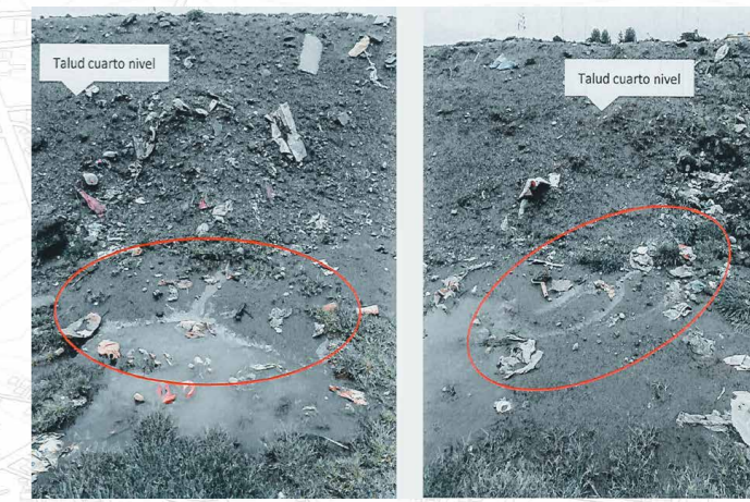
FIGURA 45: Existe la presencia de afloramiento de lixiviados líquidos (Orgánicos) en el perímetro circundante del recinto. (SMA,2020,Pág 7)
