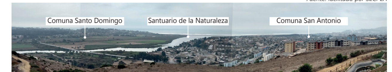
Fotografía panorámica puente a Santo Domingo y desembocadura del Río Maipo 2019 (vista desde el MUSA) Fuente: elaboración propia
