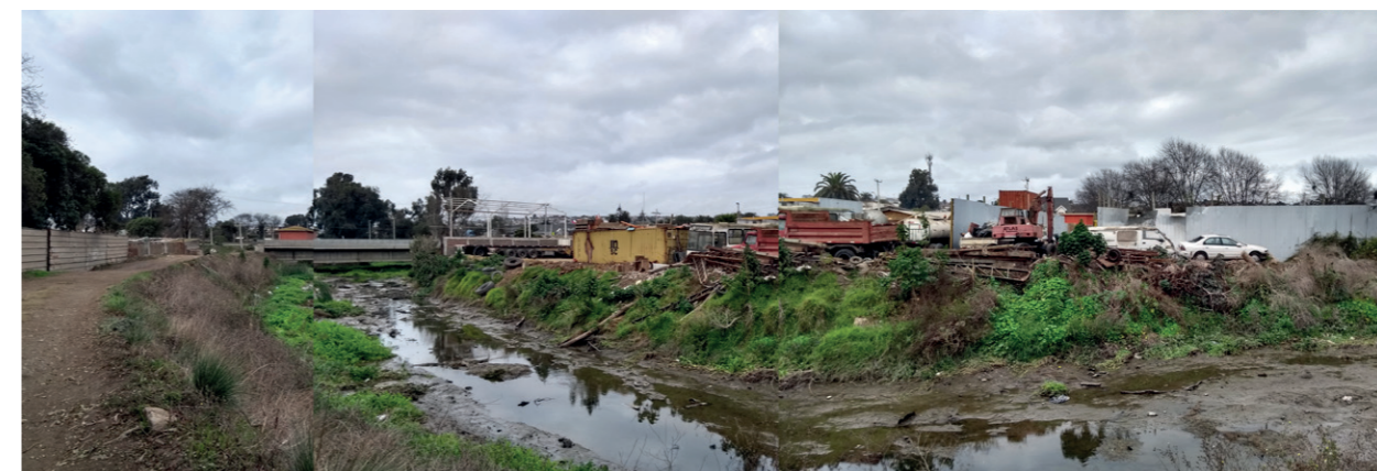
Fotografía Panorámica construida Estero El Sauce y Puente Lolleito, 2019 Fuente: elaboración propia
