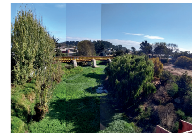
Fotografía construida Estero El Sauce y Puente Ferroviario, 2019 Fuente: elaboración propia
