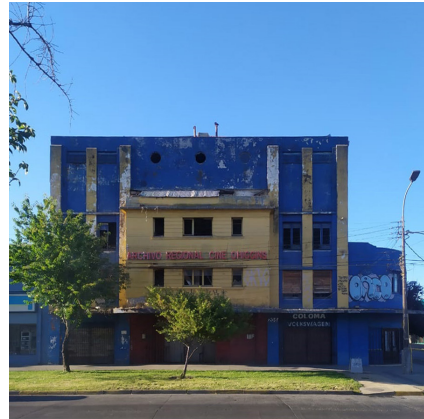
Fachada Av. Libertad Fuente: Archivo personal (2021)
