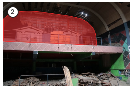
2 Muro divisor de la sala en la galería de segundo nivel.
