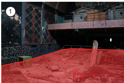
1 Eliminación de butacas en primer nivel.
