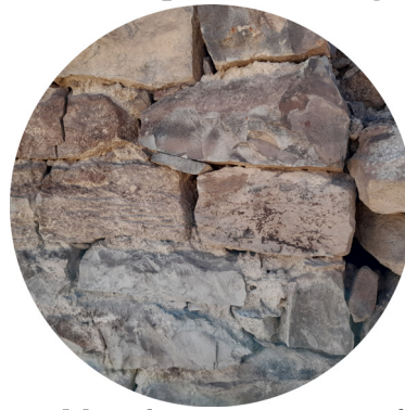
Figura 48. Muro de mampostería con aglomerante. Elaboración propia, (2021).
