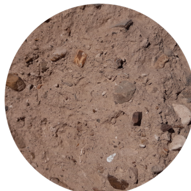
Figura 49. Muro de adobe. Elaboración propia, (2021).
