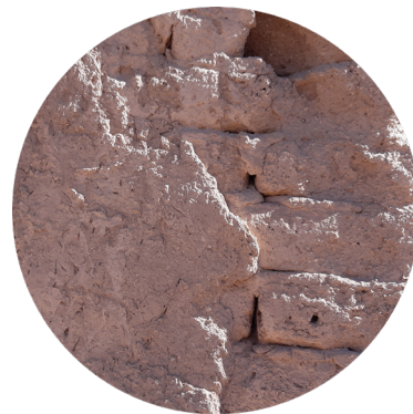
Figura 50. Muro de ladrillos de adobe. Elaboración propia, (2021).
