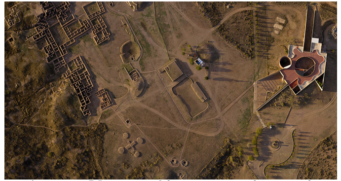
Figura 83. Vista aérea del proyecto y su relación con las ruinas de Paquimé. Recuperado de http://gdu.com.mx/gdu/portfolio/museo-de-las-culturas-del-norte-paquime/ .
