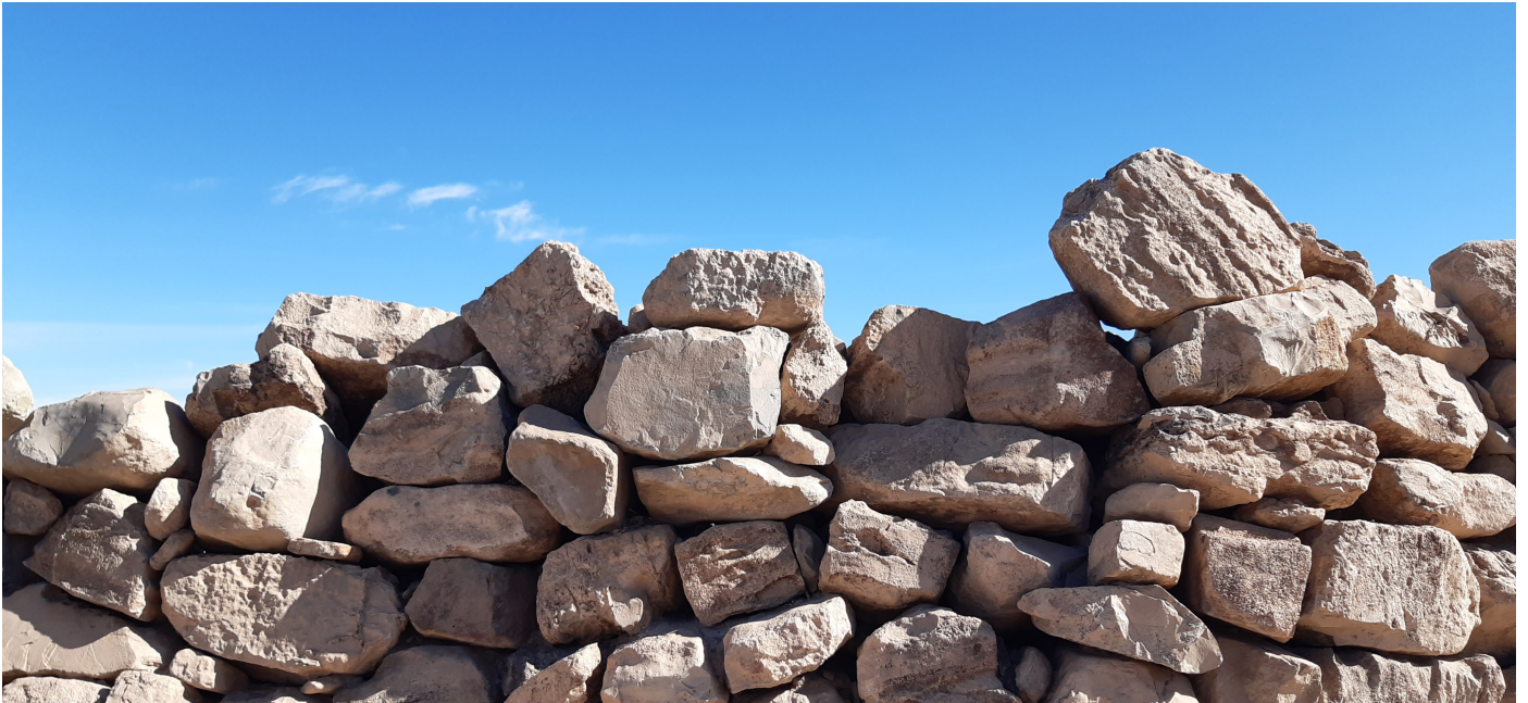
Figura 2. Ruinas de muro de mampostería sin aglomerante, Chañarcillo. Elaboración propia, (2020).
