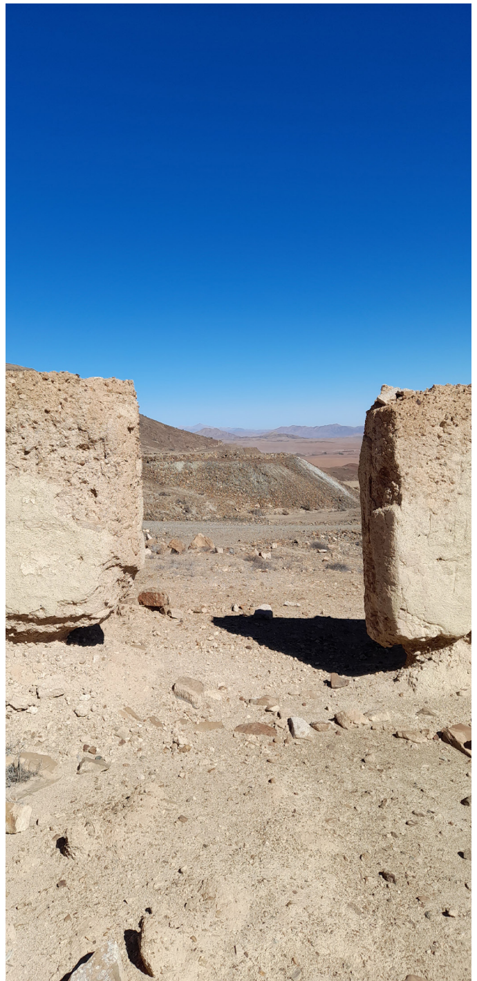
Figura 4. Muros de adobe, Chañarillo . Elaboración propia, (2021).
