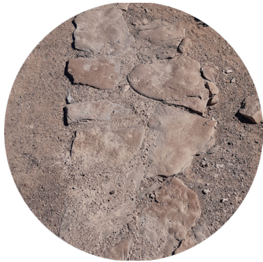
Figura 45. Textura fundación de rocas. Elaboración propia, (2021).
