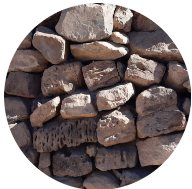
Figura 47. Muro de mampostería de piedras sin aglomerante, Elaboración propia, (2021).
