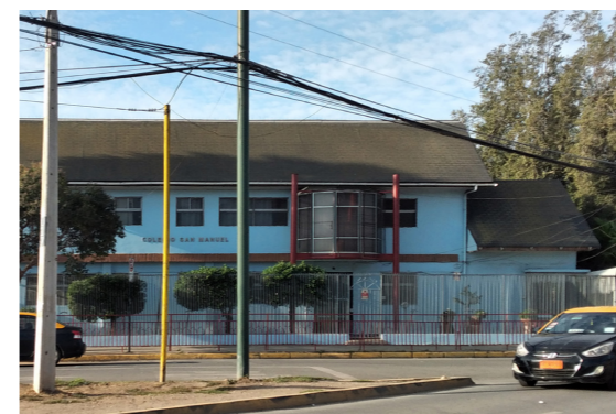
Fig. 29. Colegio en calle Polcarpo Toro Fuente: Elaboración propia (2021)
