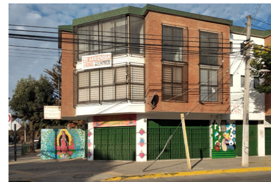
Fig. 27. Edificio en calle Correa Fuente: Elaboración propia (2021)
