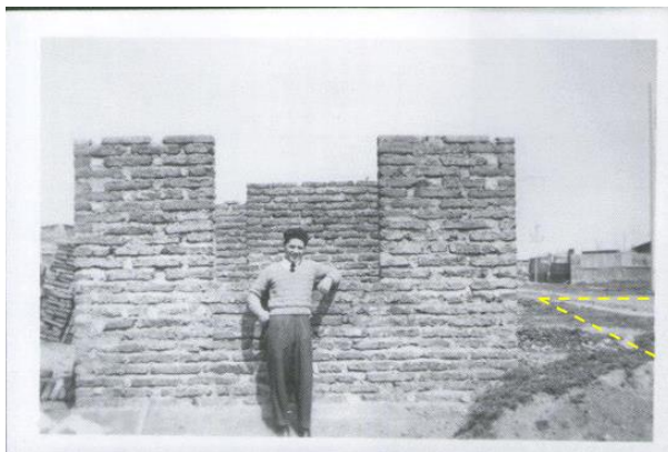
Poblador construyendo su propia casa en 1958. Fuente: memoria PAC
