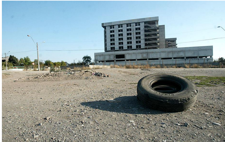
Sector Ochagavía, vista hacia el hospital abandonado en la década del '90. Fuente: memoria PAC
