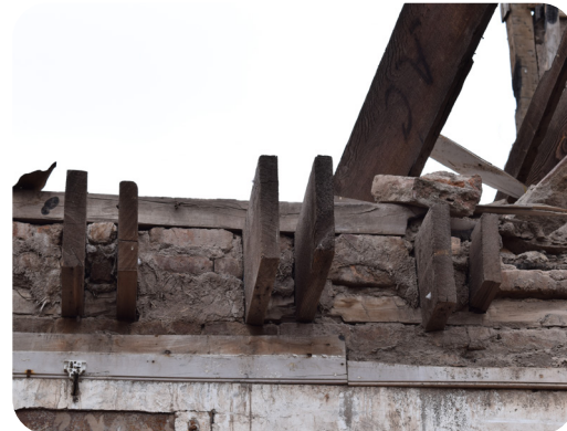
Figura 84. Envigado de piso. Fuente: Elaboración propia.
