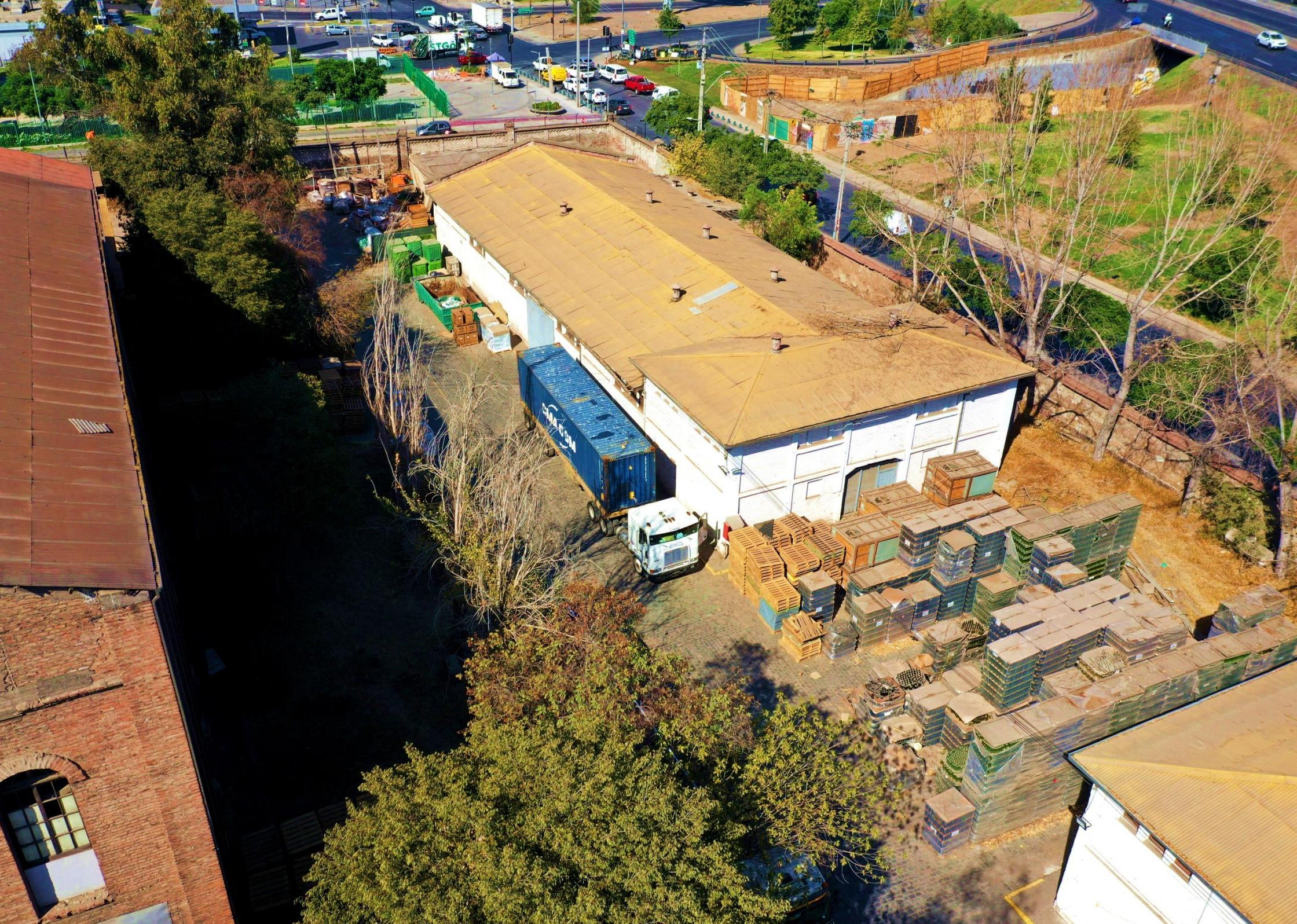
Por último, los galpones construidos en la última etapa del conjunto responden a una tipología constructiva de muros exteriores autosoportantes de albañilería confinada de 25 cm de espesor. Los vanos de las fachadas están realizados en base a pilares y cadenas de hormigón armado que constituyen vanos mucho más grandes en comparación con los galpones anteriores. Por último, la estructura de techumbre está compuesta por cerchas metálicas que soportan una cubierta a dos aguas de planchas metálicas.
