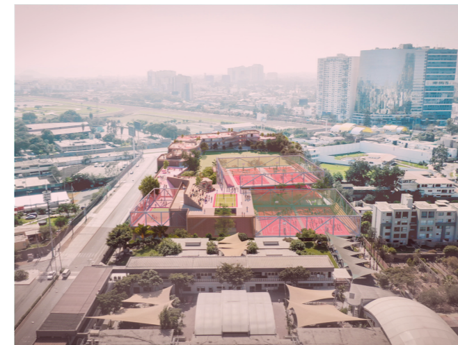
Fig. 18. Escuela de primaria del Markham College, Lima, Perú. “escuela a prueba de pandemias” Fuente: Rosan Bosch/ IDOM, 2021.
