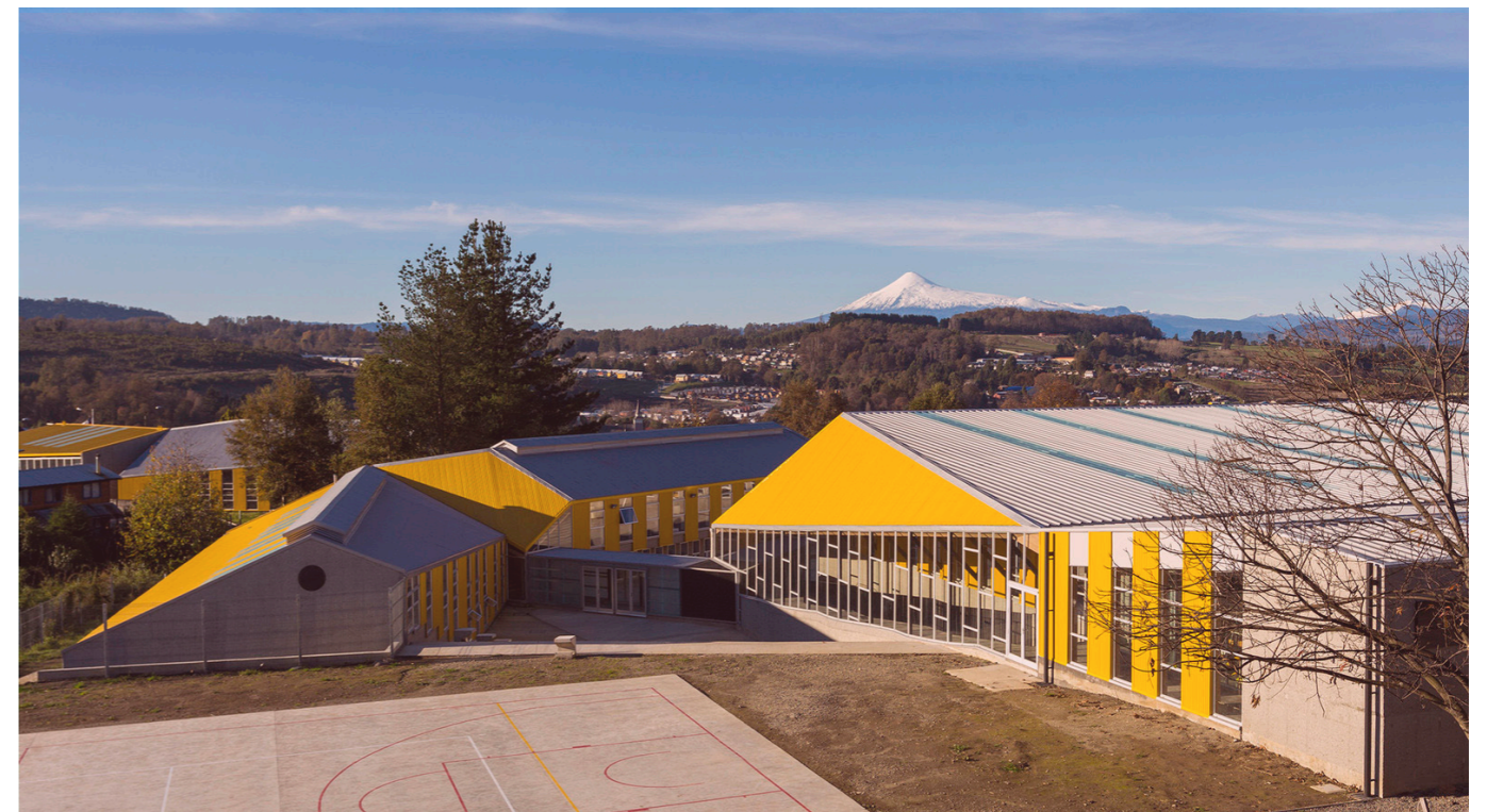
Fig. 30. Edificio Escuela Manuel Anabalón Saez- Gubbins Arquitectos. Vista de la pertinencia arquitectónica en la utilización de edificios con techumbre a dos aguas, siguiendo tipologías rurales, características del lugar. Además de una concordancia de esta volumetría con el paisaje y la pendiente. Fuente: Mendizabal, M. Plataforma Arquitectura, 2014.
