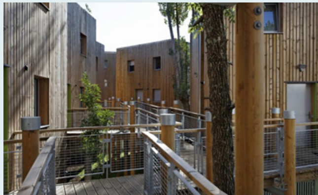
Pasarelas de madera que conectan las viviendas colectivas.
