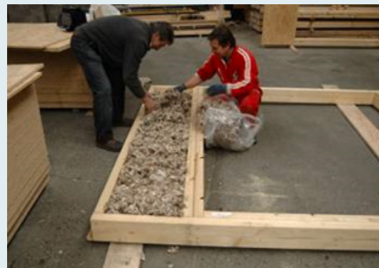
Utilización de lana de oveja como aislante natural.
