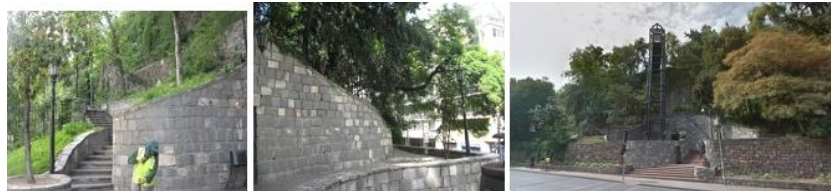
Imagen 20 Ascensor. Elaboración propia.
